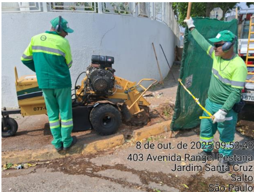
Destocamento de árvores
